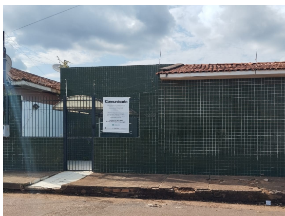
Fachada do Avaliando
